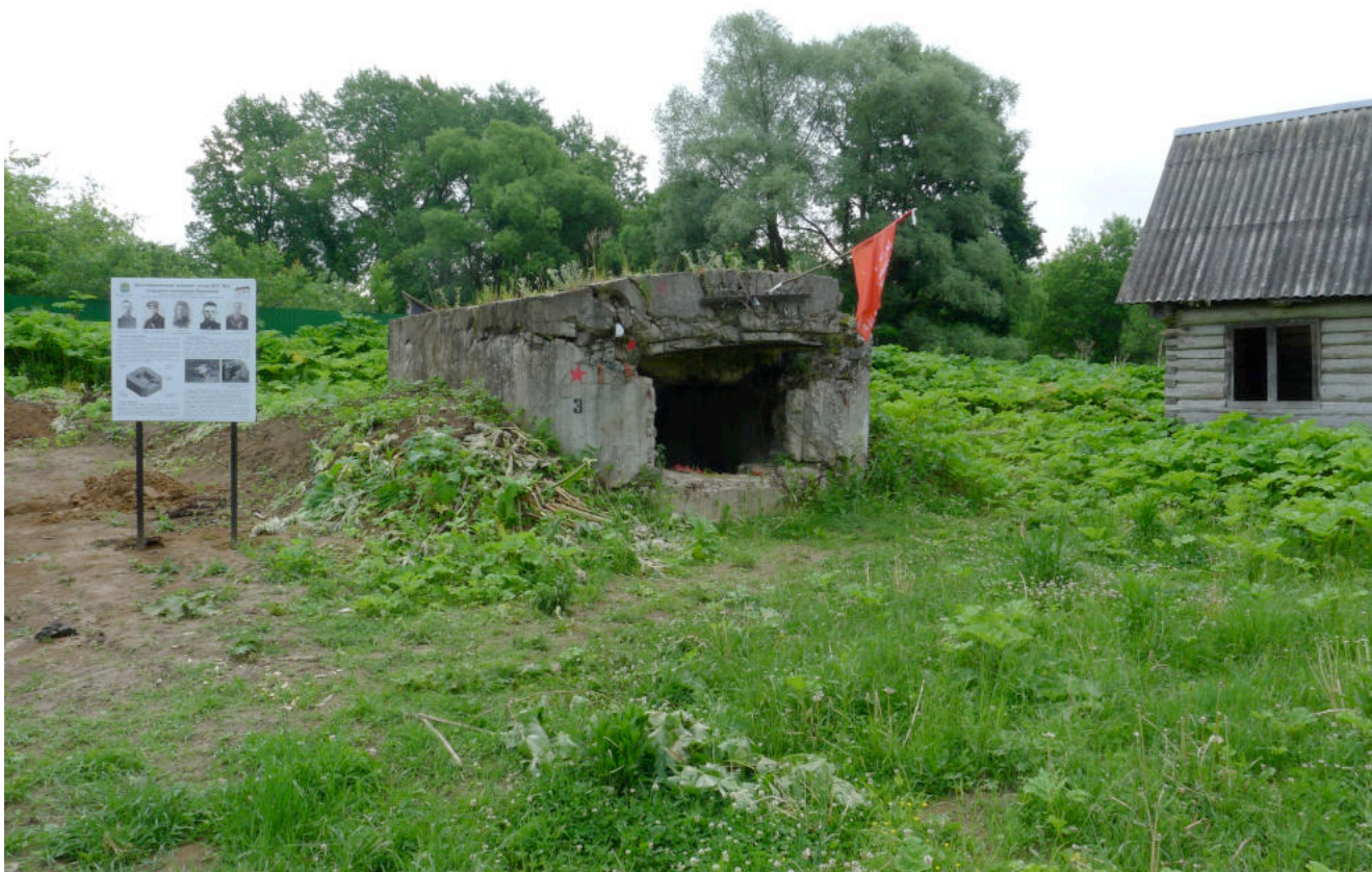
Фото 22. ДОТ № 3. Вид с северо-запада.
