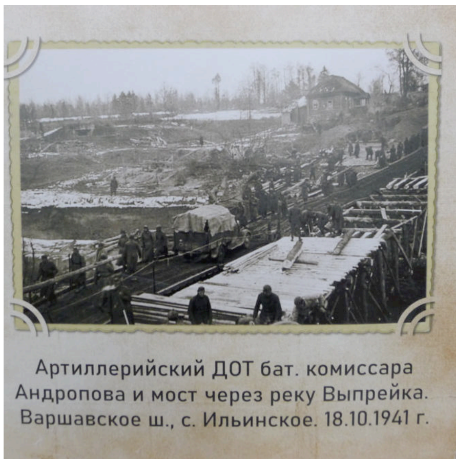
Фото 3. Временная переправа через р. Выпрейку, сооруженная после взрыва моста. Немецкое фото 18.10.1941 г. Вид с юго-запада. Из экспозиции Военно-исторического музея «Ильинские рубежи».
