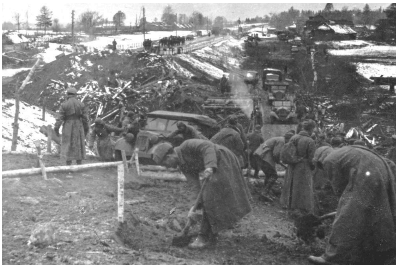
Фото 2. Взорванный мост через р. Выпрейку и временная переправа. Вид с востока. Октябрь 1941 г. Снимок из фондов Военно-исторического музея «Ильинские рубежи».
