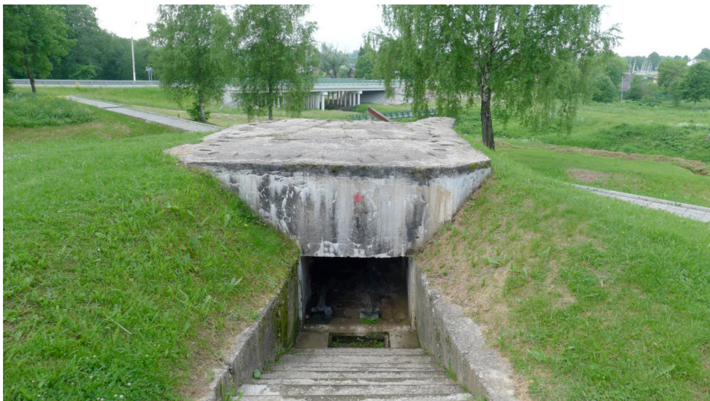
Фото 10. Вход в ДОТ № 1.
